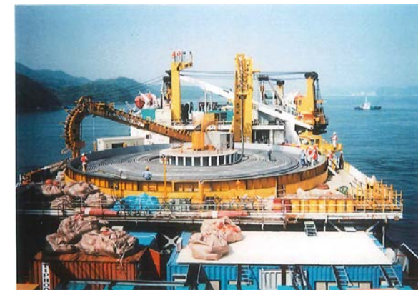
海底線布設作業
