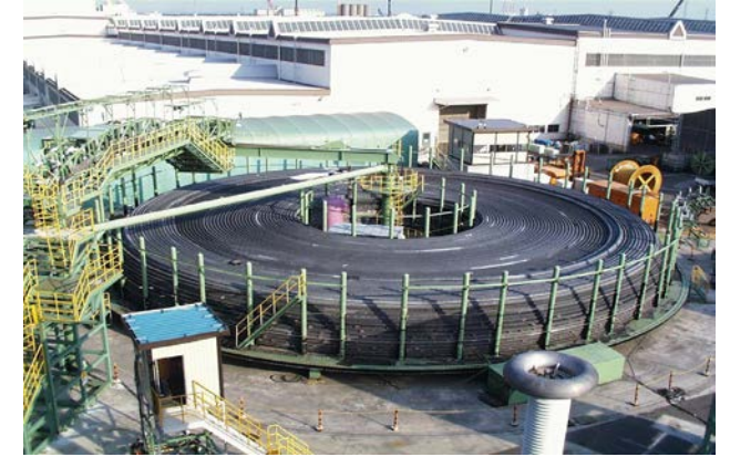
海底線製造設備(千葉工場)
