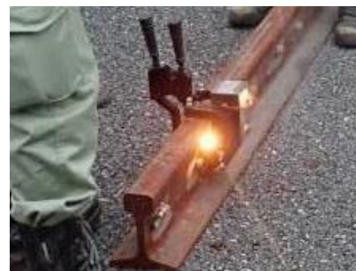
銅テルミット溶接施工風景
