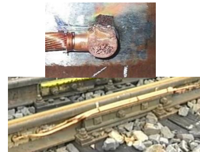
銅テルミットレールボンド溶接部
