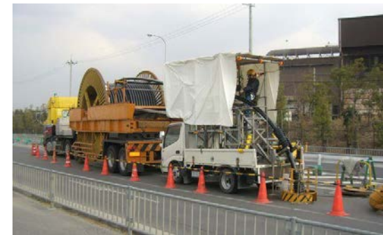
施工工事現場
