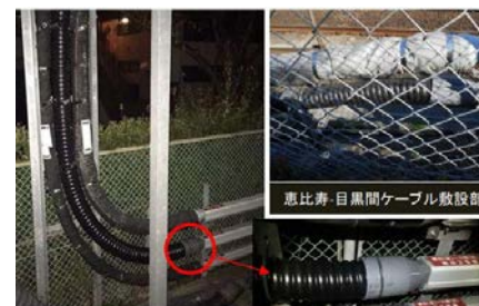
ケーブル立上り箇所敷設状況
