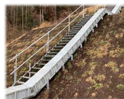
傾斜地トラフ橋
