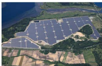
六ヶ所ソーラーパーク 再生エネ案件で国内初の154kV級採用
