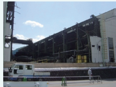
全面復旧に向けた作業が続く工場
