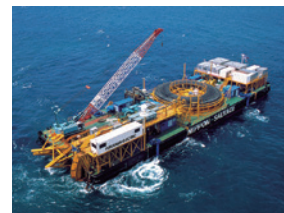
海底送電ケーブル敷設の様子
