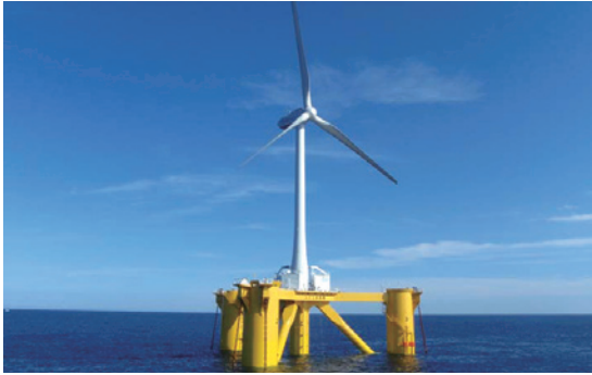
浮体式洋上風車タワー
