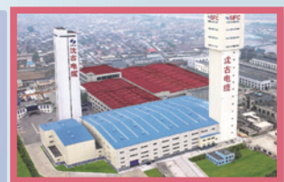
生産工場 瀋陽古河電纜有限公司
