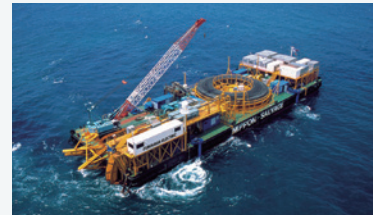
海底送電線敷設工事
