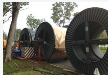
超高压電力ケーブル敷設工事現場
