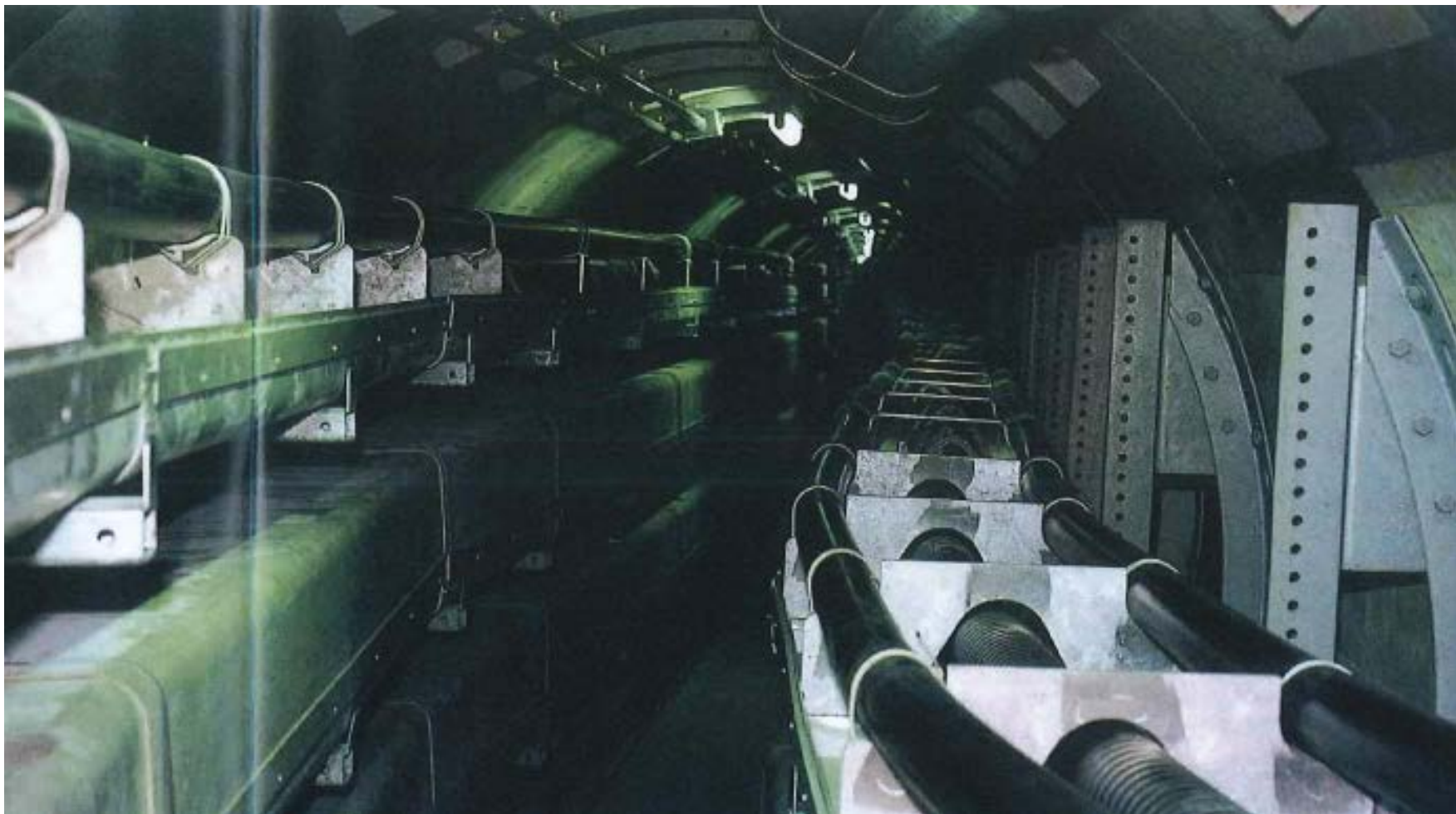
超高压ケーブル 施工例（洞道内）
