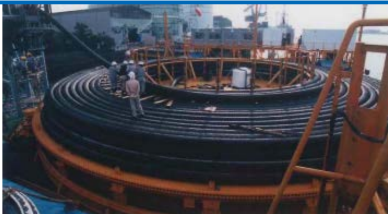
海底ケーブルの積込
