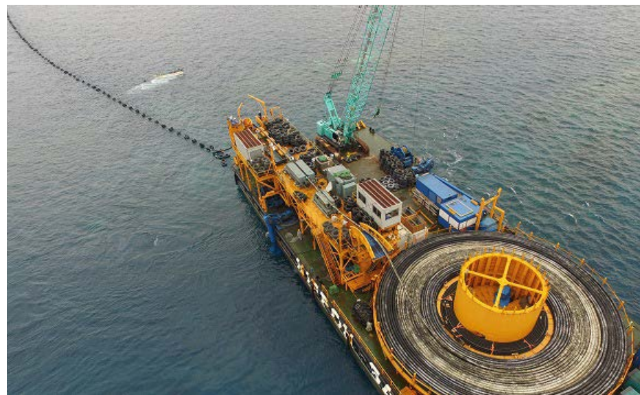
海底送水管の布設
