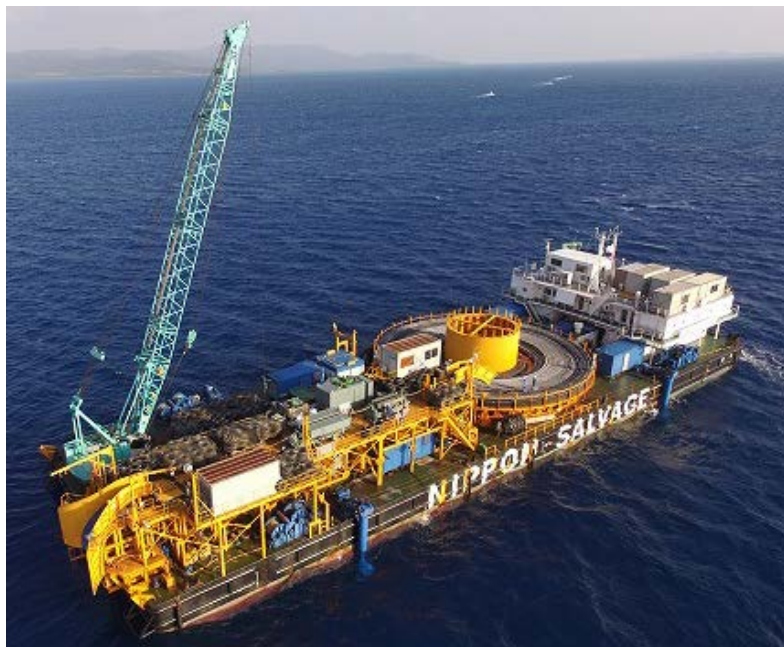
海底送水管の布設
