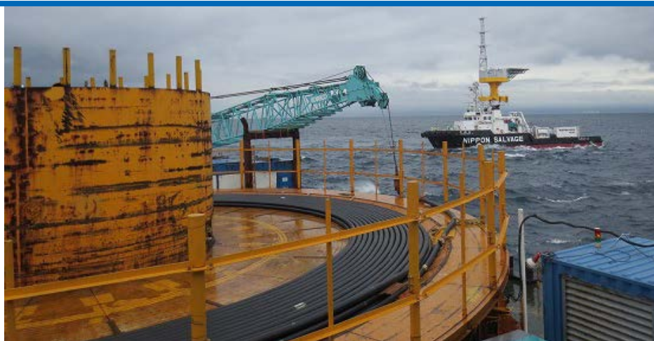
海底ケーブルの布設
