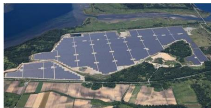
六ヶ所ソーラーパーク 新エネ案件で国内初の154kV級採用
