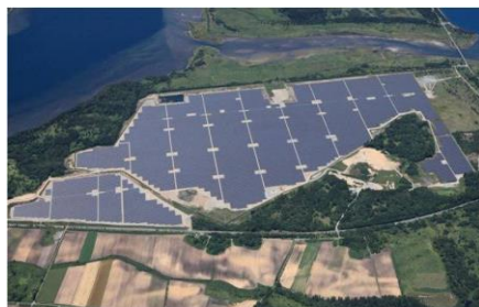
六ヶ所ソーラーパーク 新エネ案件で国内初の154kV級採用
