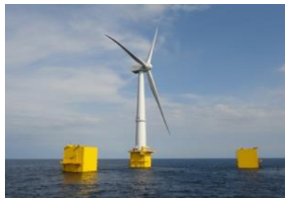
福島浮体式洋上風力実証研究
