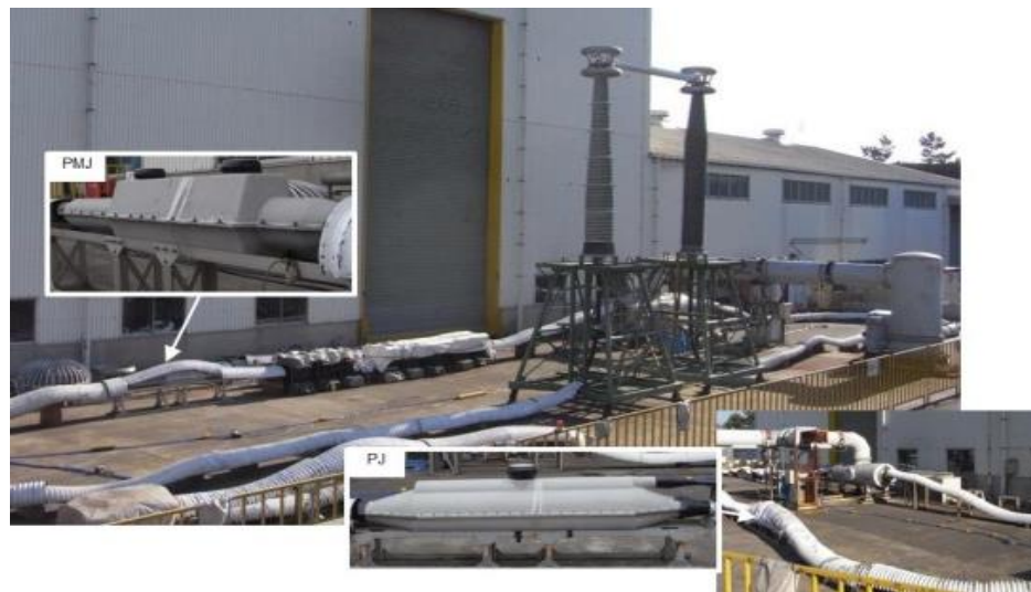
超高压電カケーブル開発試験
