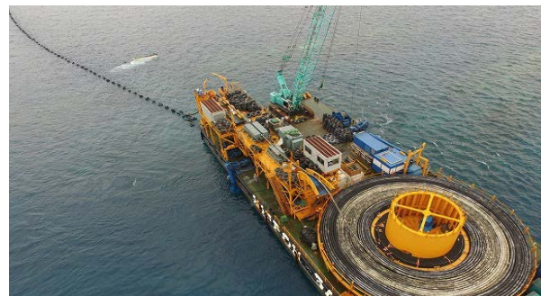
海底送水管の布設
