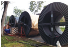
超高压電力ケーブル敷設工事現場
