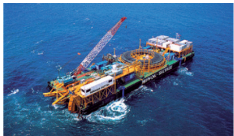
海底線布設工事
