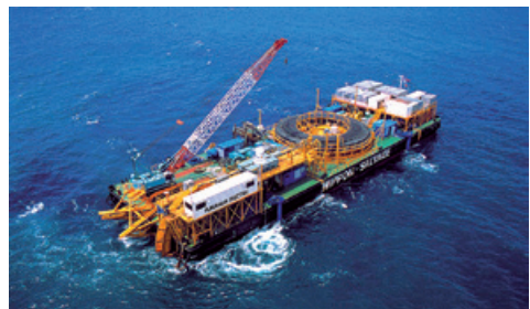
海底線布設工事
