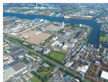
電力ケーブル製造工場を含む千葉事業所
