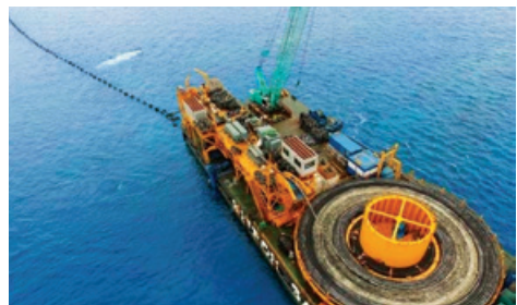
海底線送水管布設
