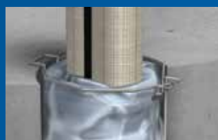
4 押さえ金具を設置して 施工完了。
