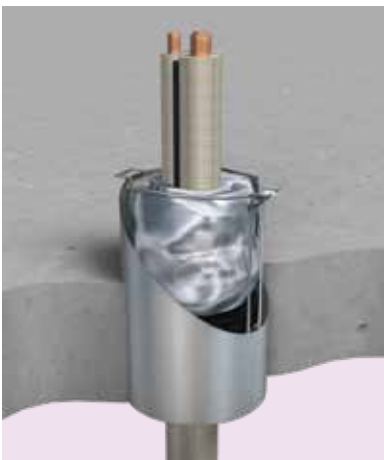
RC・ALC床(スリーブ埋設) PS060FL-0734
