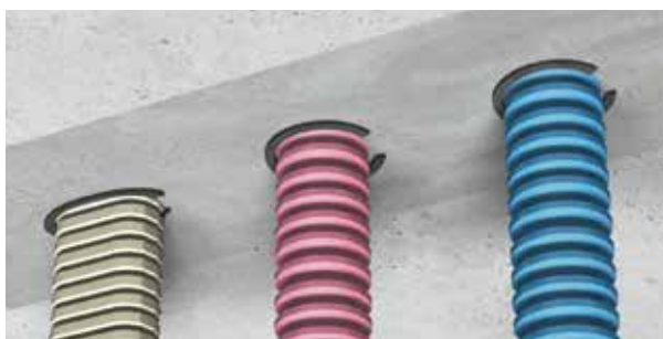
RC・ALC床(床下施工) KK19-084号, KK23-016号, KK24-018号
