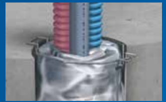
4 押さえ金具を設置して 施工完了。
