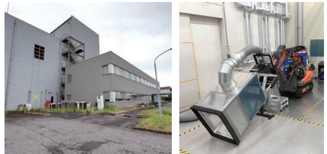
図4 当社千葉事業所に開設したインフラレーザラボ 左: 建屋外観, 右: インフラレーザラボ内の実験スペース The InfraLaser Lab opened at our Chiba Works. Left: Exterior view of the building, Right: Experiment space in the InfraLaser Lab.
