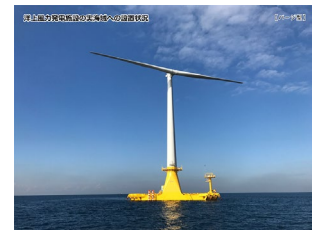
浮体式洋上風力発電の 実海域への設置状況
