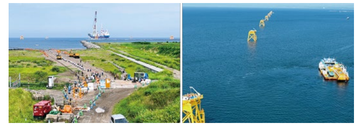
石狩湾新港洋上風力発電事業 布設写真
