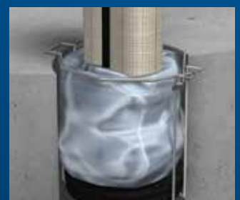
4 押さえ金具を設置して 施工完了。
