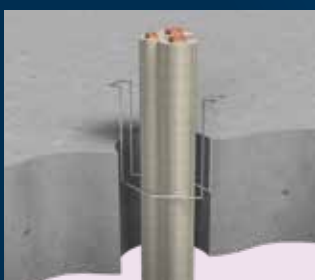
1 支え金具の設置。
