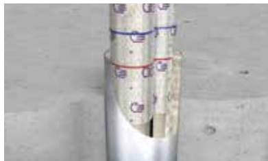
RC・ALC床 スリーブ埋設 PS060FL-1251
