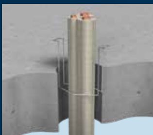
1 支え金具の設置。
