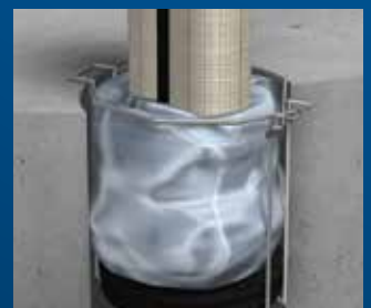
4 押さえ金具を設置して 施工完了。
