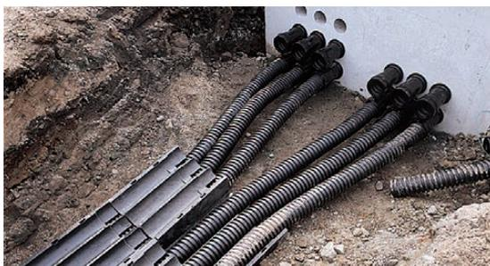
②構造体ユニットを壁厚内に入れモルタル打ちすることにより、不平等沈下・地震などによる剪断荷重に強い構造となります。
