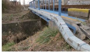
軽量で橋りょう部などの構造物に重量負荷を掛けずに施工可能。
