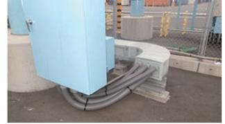
エフレックスなど他管路との接続も容易で、隙間なく施工が可能。
