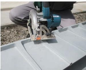
直管を加工することで任意の角度で左右曲げ、上下曲げを行うことができます。
