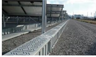
地上敷設で施工スピードUP。掘削の必要なし。
