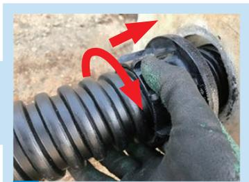
4 アクアナットを壁面にきつく接するまで回しながら締め込む
