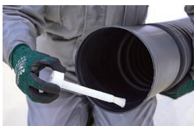
メス側継手の内面に滑剤を塗布
