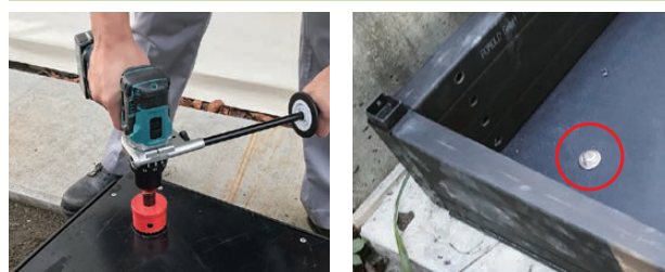
底面への水抜き穴を加工。
