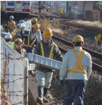
コンクリートに比べ約1/4の重量で、重機を使わずに施工が可能。狭小地や法面等、特殊な場所での施工も可能。
