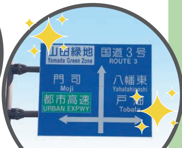
劣化がなければ スルーしたい
