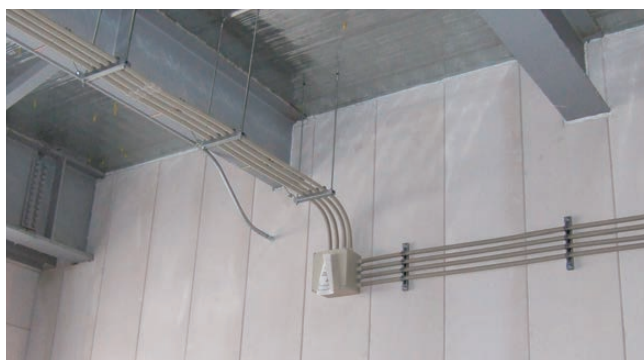
まっすぐなパイプできれいに配管
