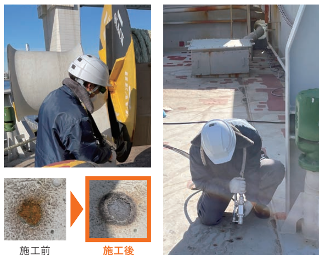
図16 貨物船甲板でのインフラレーザによるレーザ施工の事例 Case study of laser construction using an InfraLaser on a cargo ship deck.
